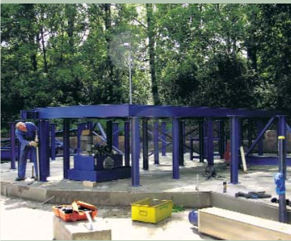
Siloplattform als schwere Stahlunterkonstruktion in geschraubter Ausführung
